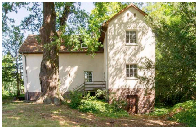
Haus Bestand vor Umbau / Strassenseite (o.) und Gartenseiten (u.)
