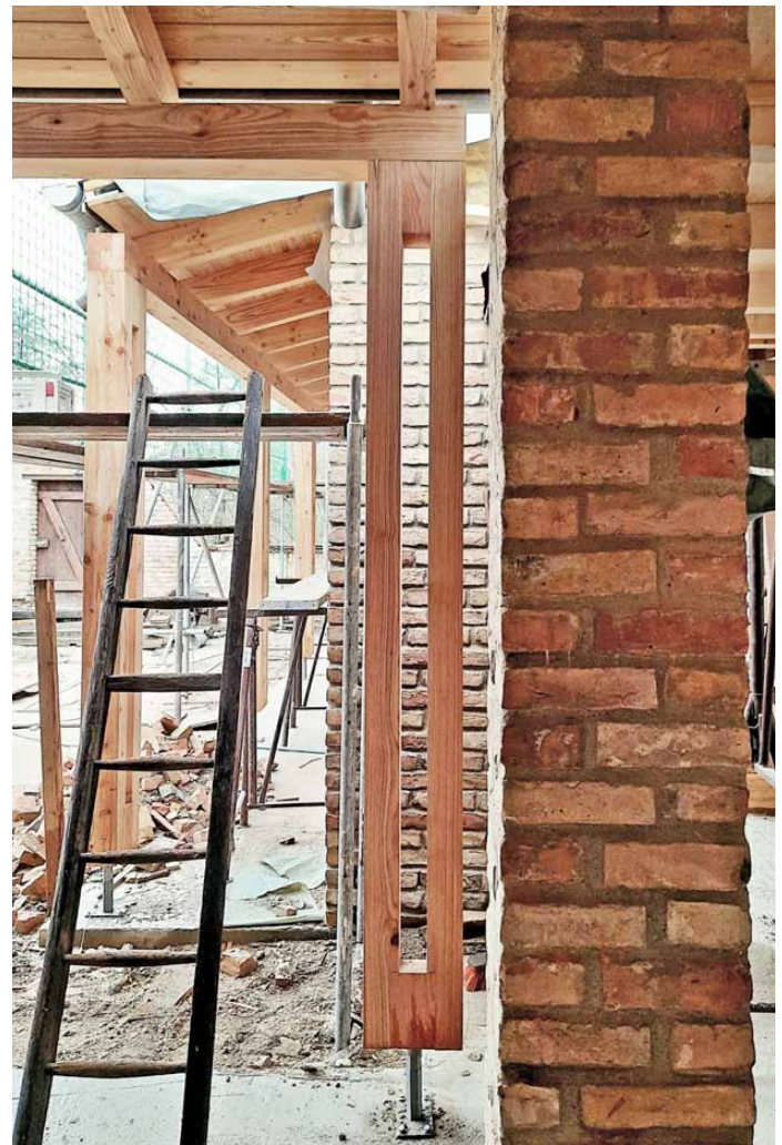
Winkelhaus / innere Ecke, Blick in Loggien / Rohbau
