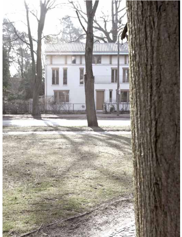
Strassenansicht Domstrasse / Konrad-Adenauer-Platz
