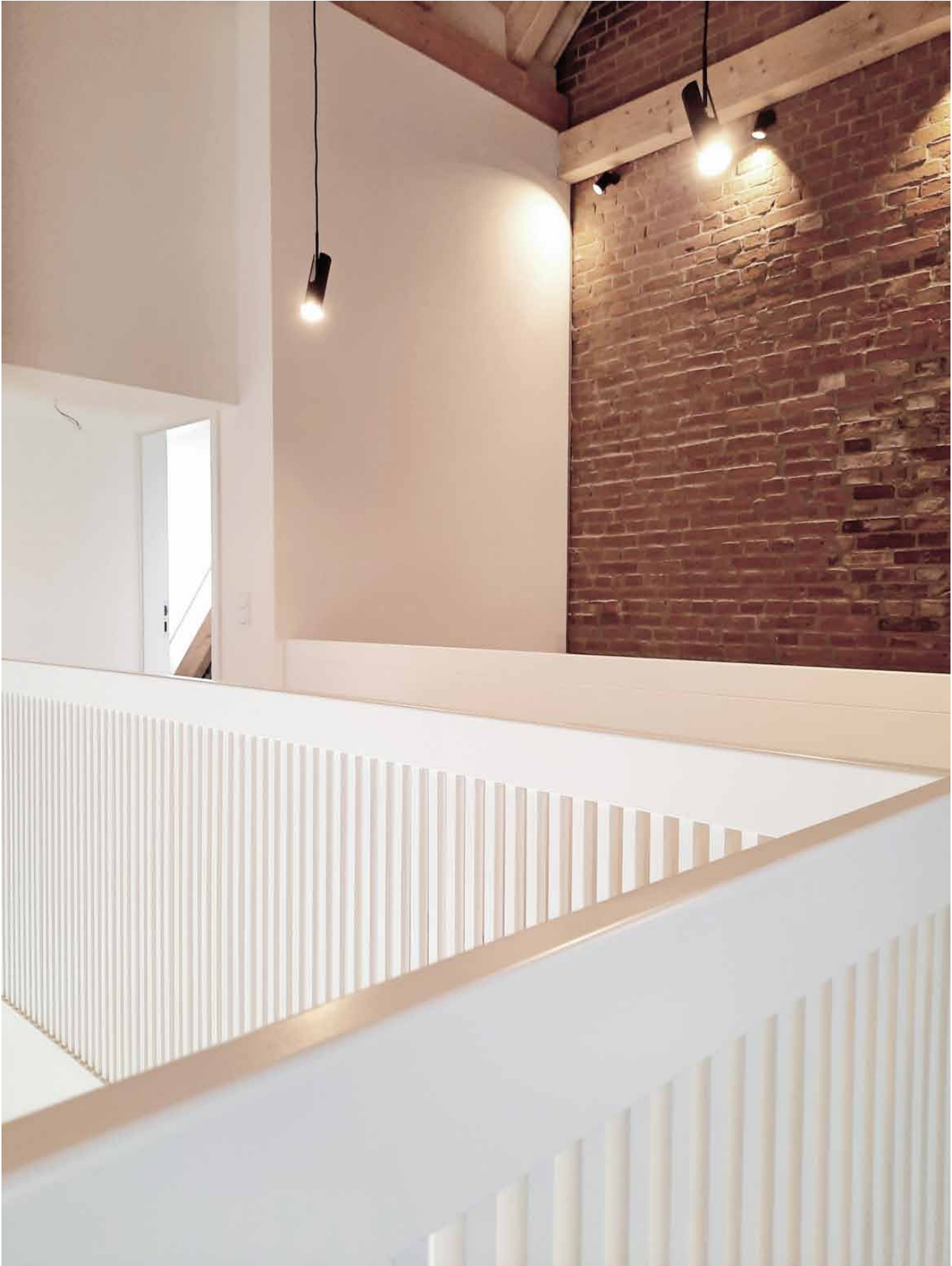
Umbau mittlere Scheune mit Patiohof, Innenraum
