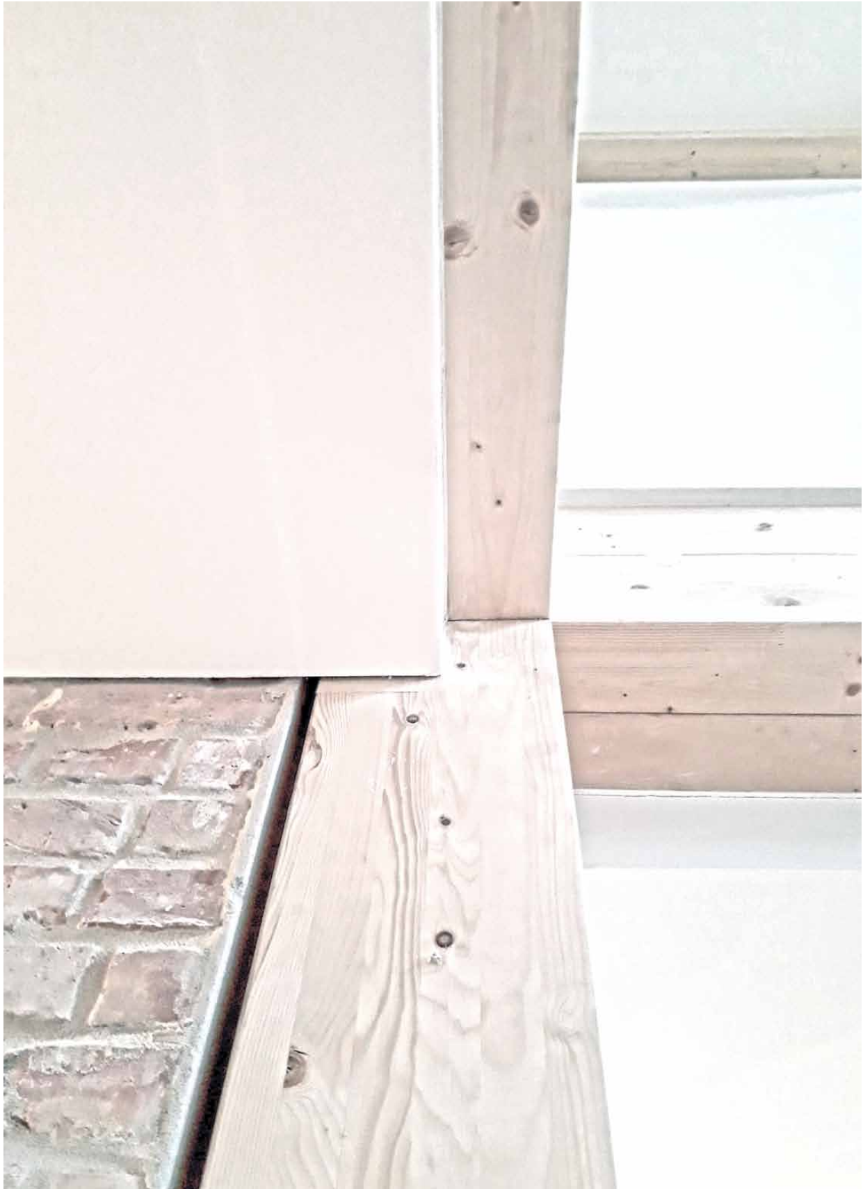
Stützenvering EG / Detail
