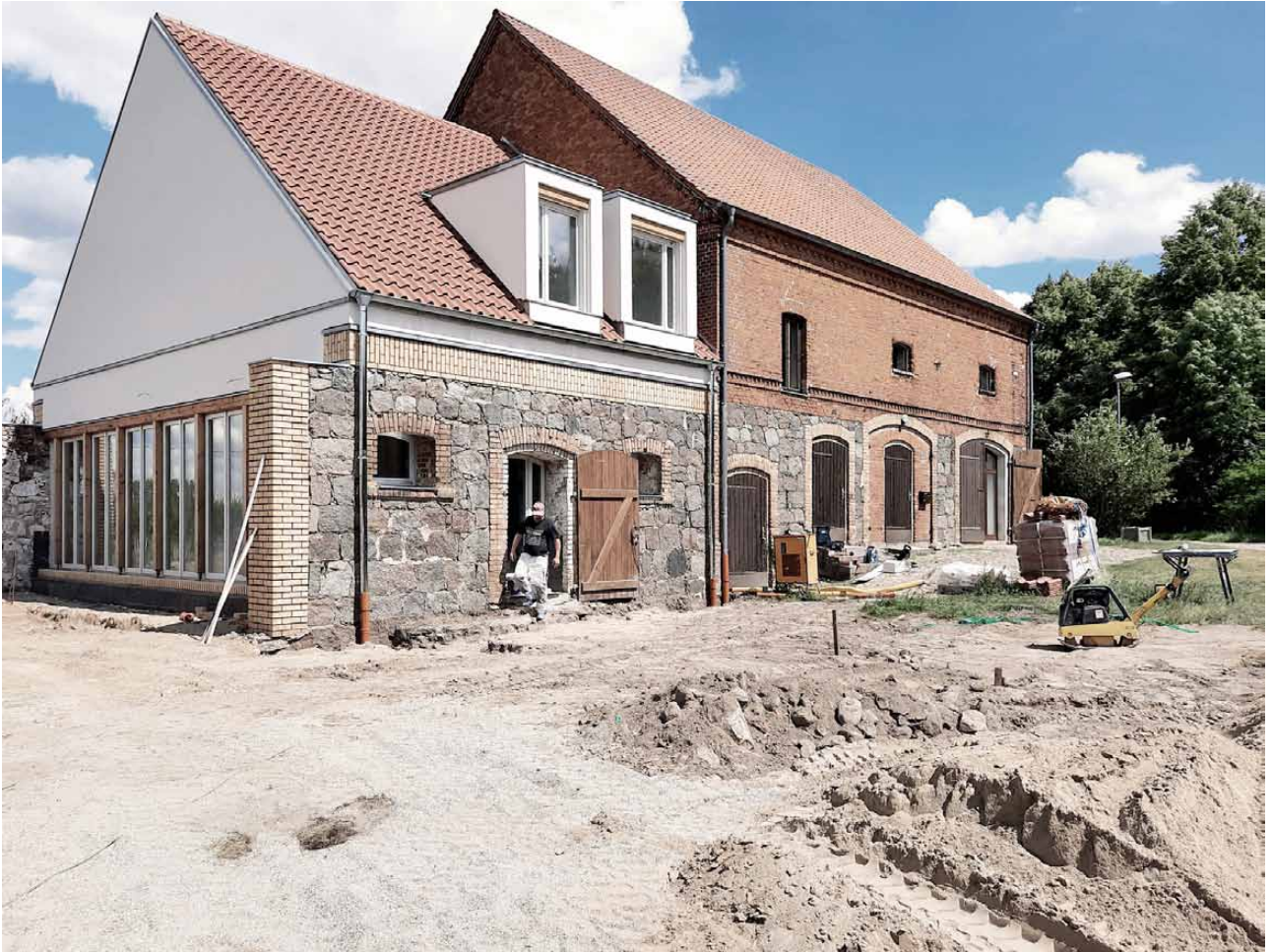
Umbau mittlere Scheune mit Patiohof
