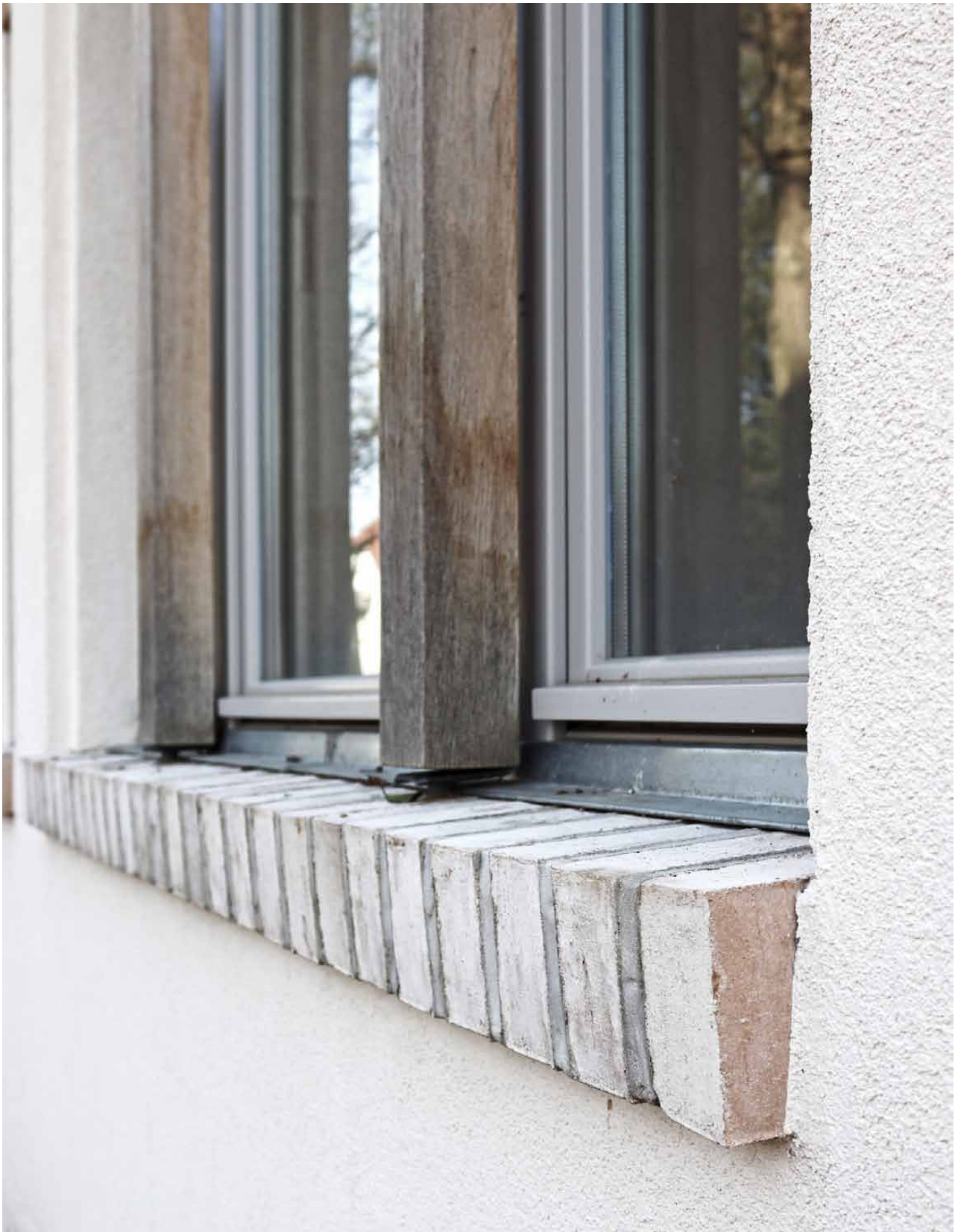
Fassade / Detail Eichenholzstützen
