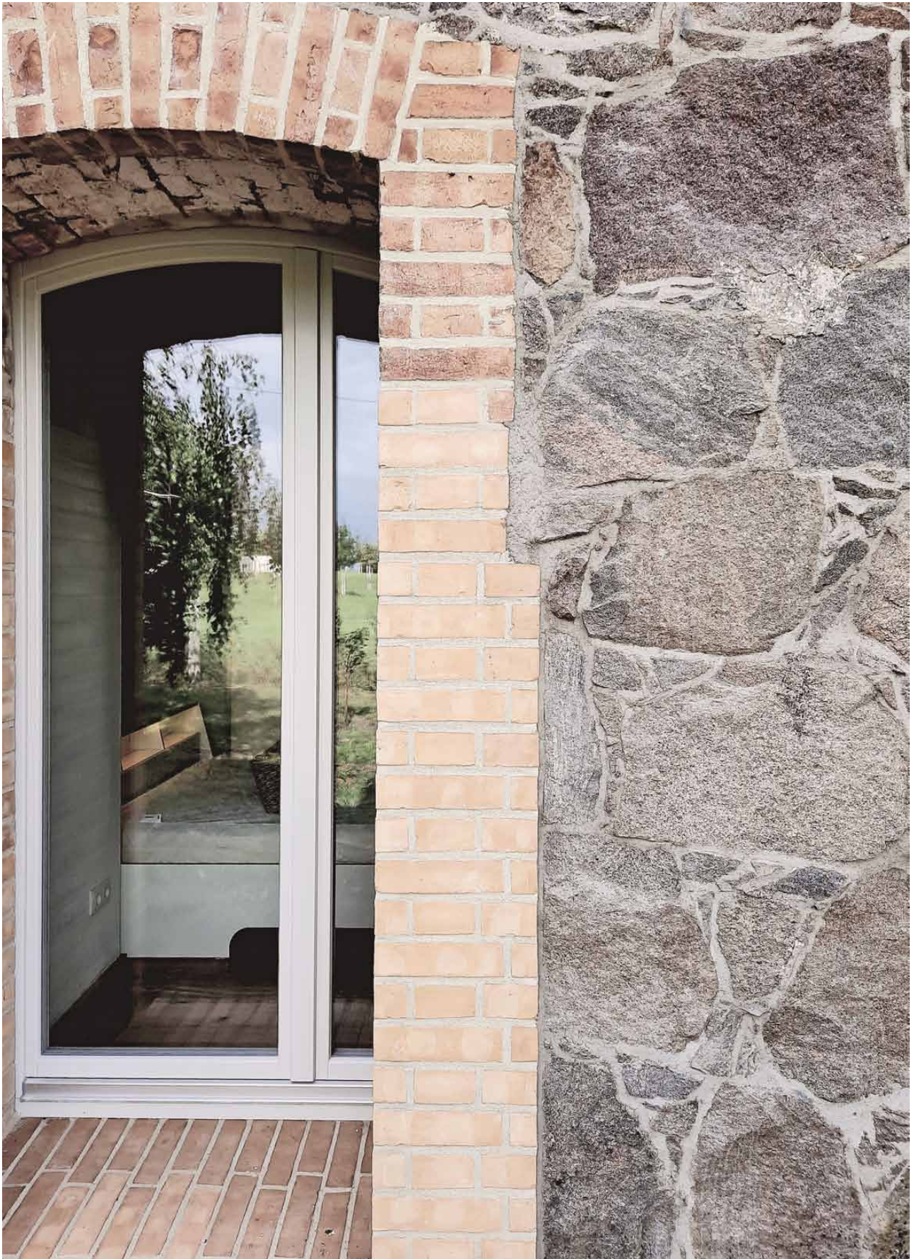
Umbau mittlere Scheune mit Patiohof, Fassadendetail
