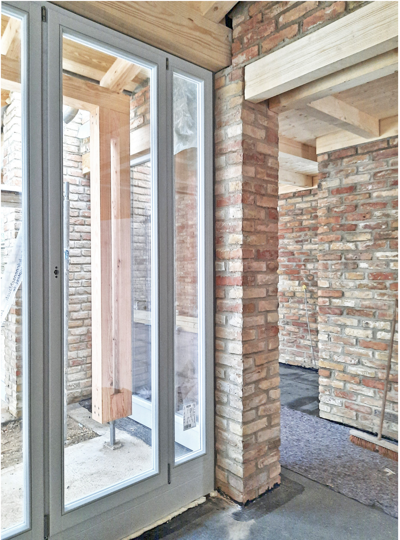
Winkelhaus, Innenecke / Rohbau
