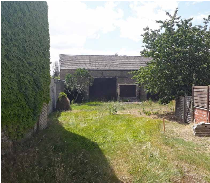
Altbestand: Historische Scheune
