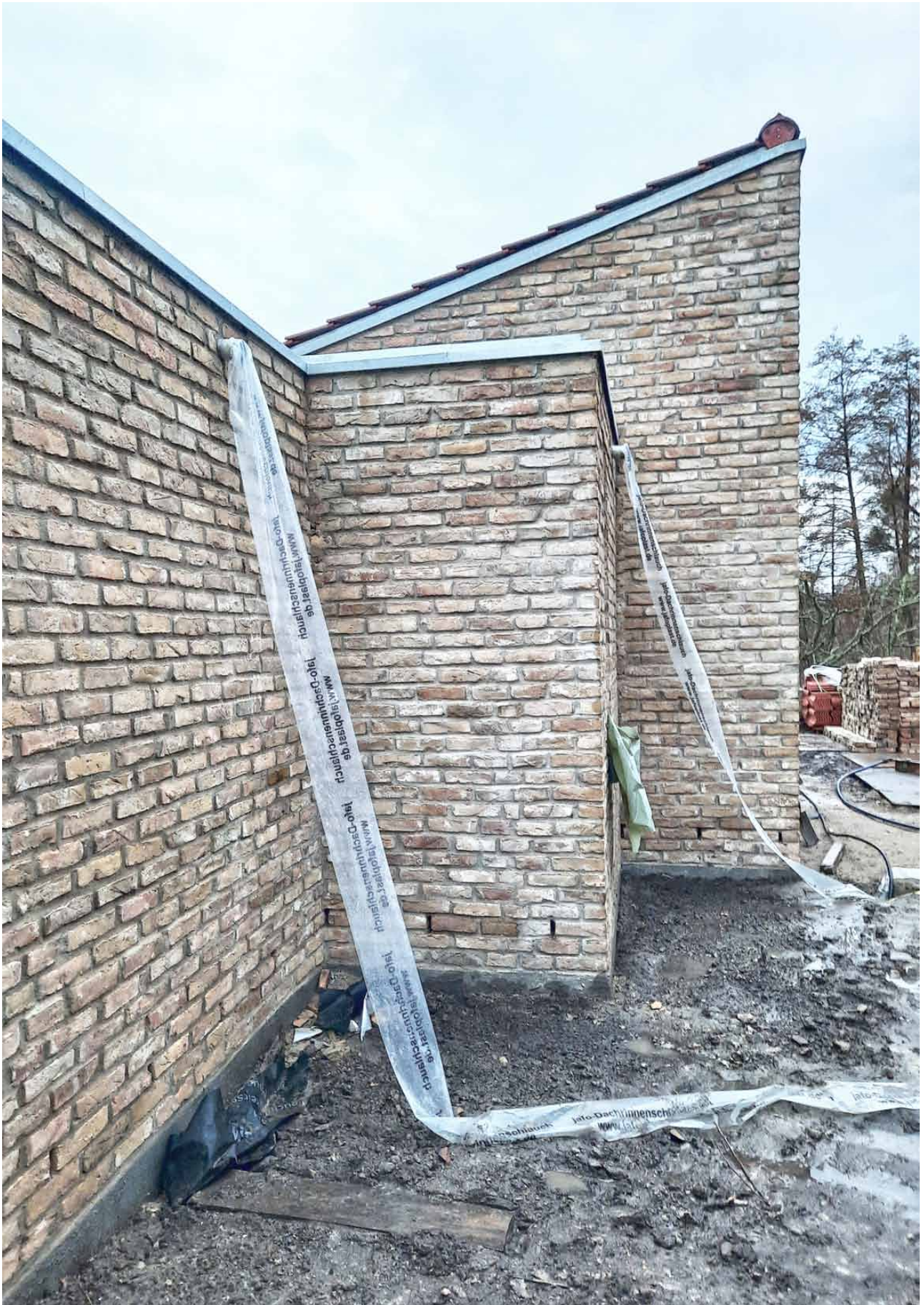
Fassade Nord / Bauphase
