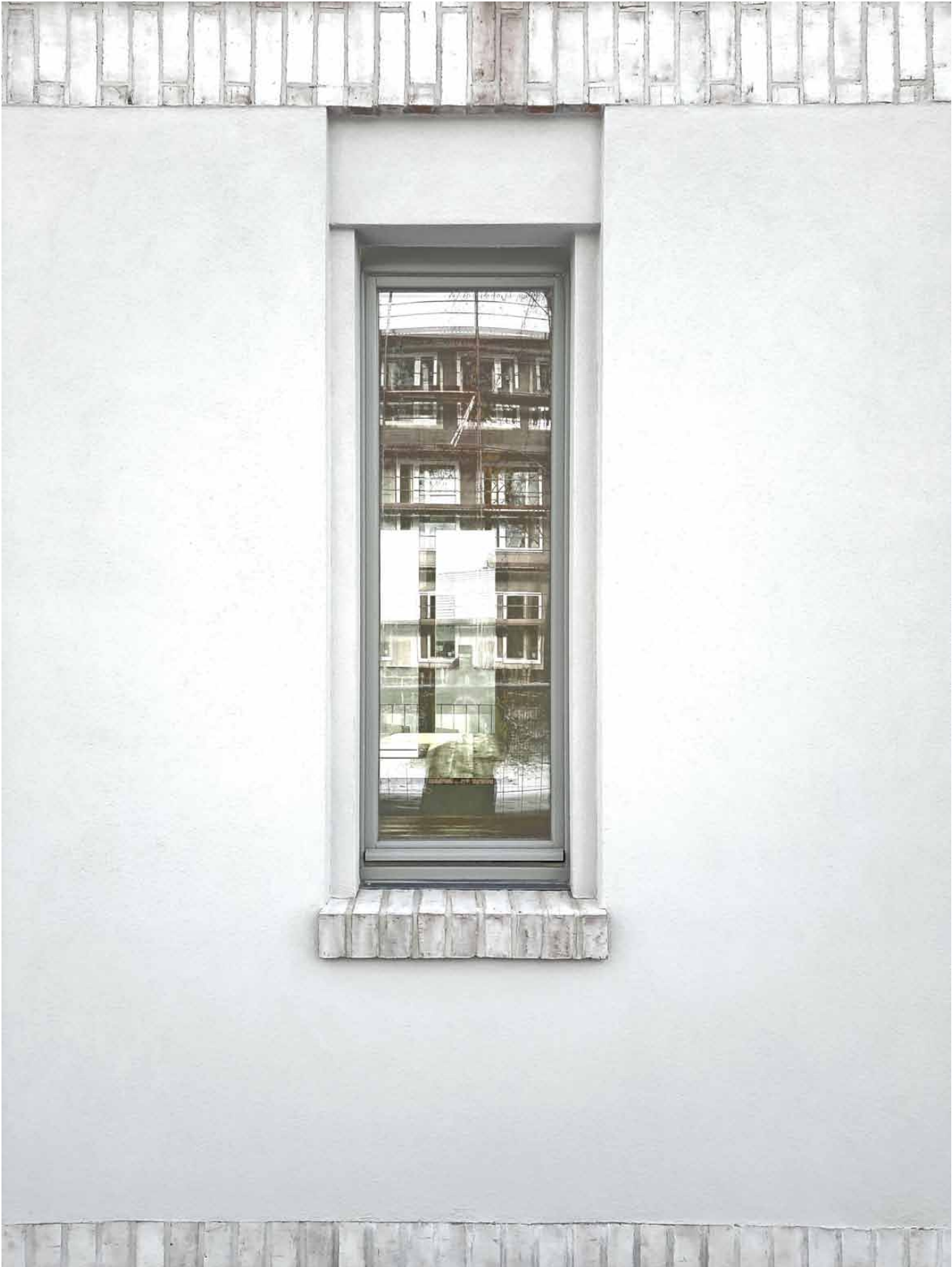
EFH / Fassade Nord mit Klinkerbändern / Fenstersturz
