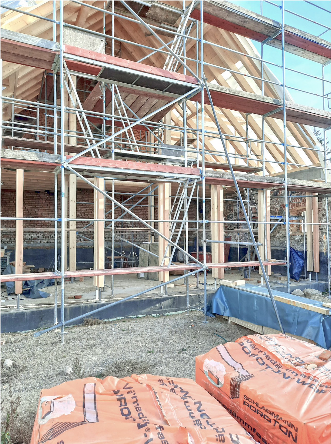
Erster Bauabschnitt des Umbaus der mittleren Scheune mit Patiohof
