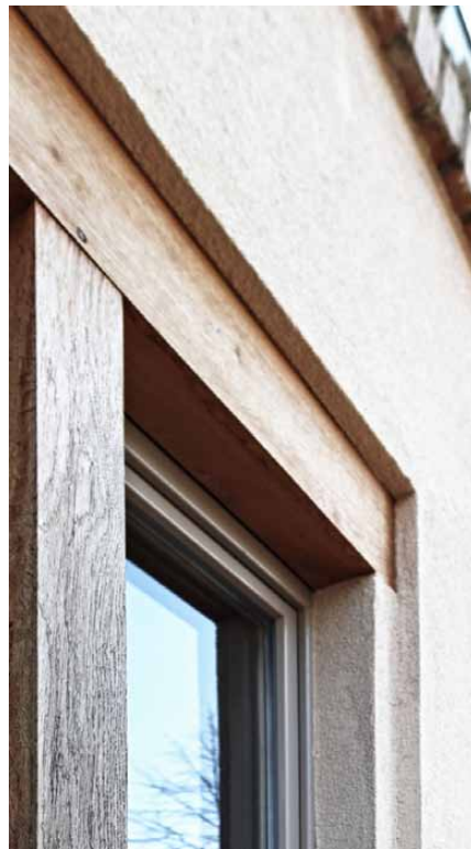
Fensterdetail mit Eichenholzsturz / Fertigstellung
