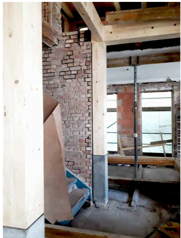
Stützenverierung in der Eingangshalle / Holzstützen auf Sichtbetonsockel / Bauphase
