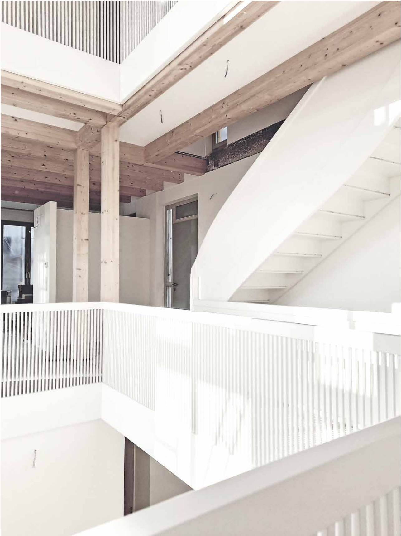
EFH / Zentraler Luftraum OG, vor Fertigstellung
