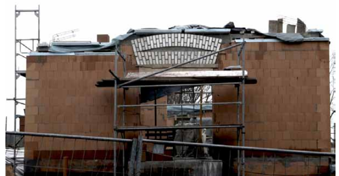
Scheitrecte Bogenkonstruktionen: Bauzeichnungen und Rohbau
