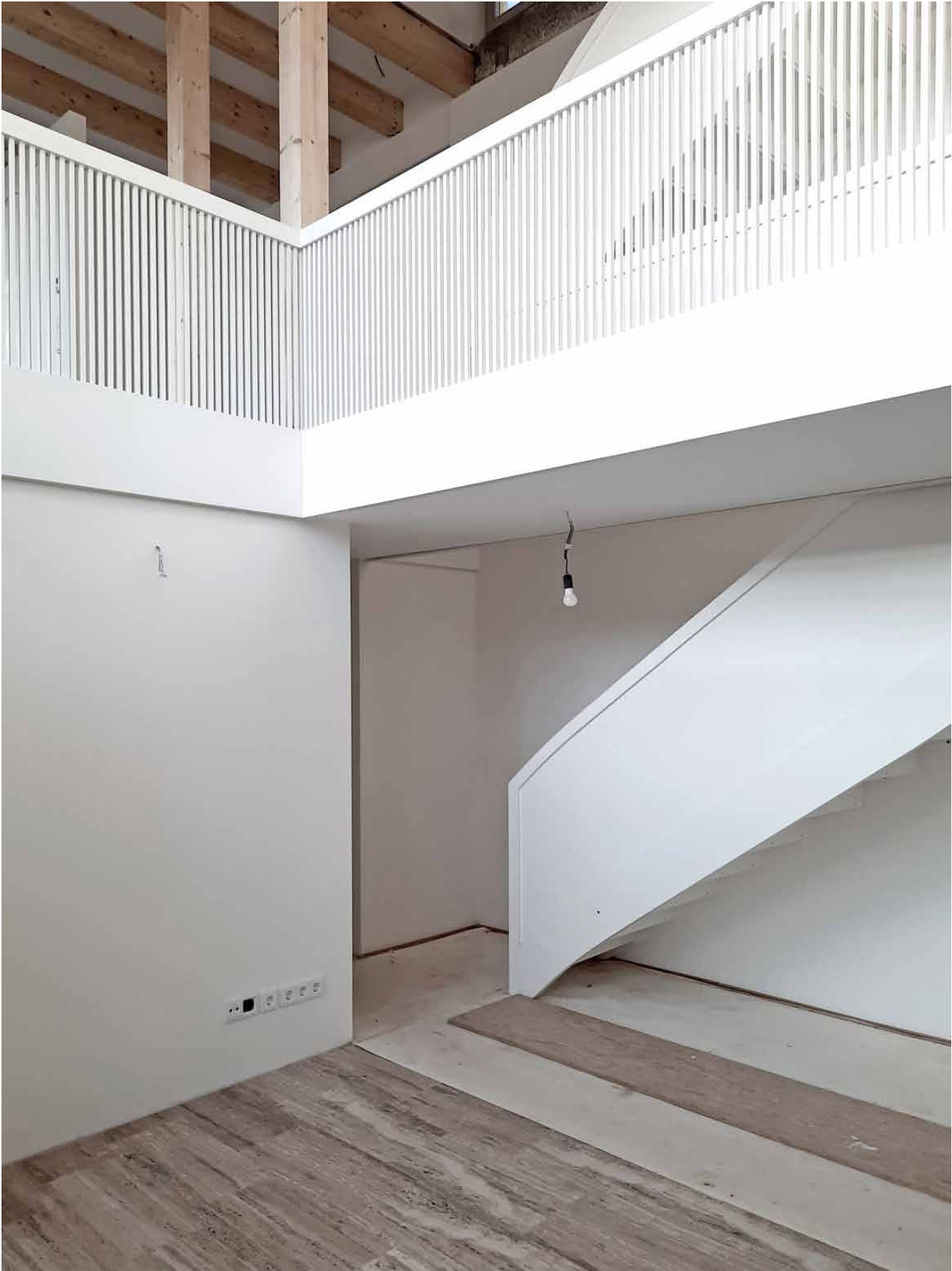
EFH / Zentraler Luftraum EG, vor Fertigstellung
